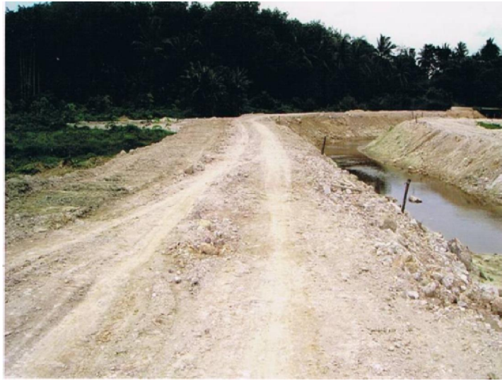
การก่อสร้างคันกั้นน้ำ ยาว 560.00 เมตร
