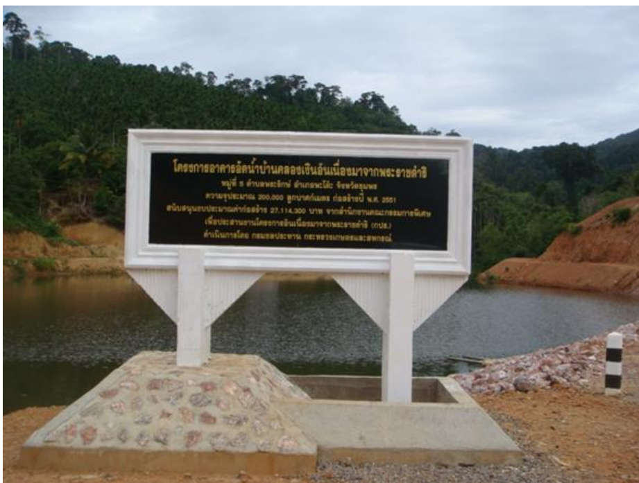
บริเวณหัวงานอาคารอัดน้ำบ้านคลองเงินอันเนื่องมาจากพระราชดำริ
