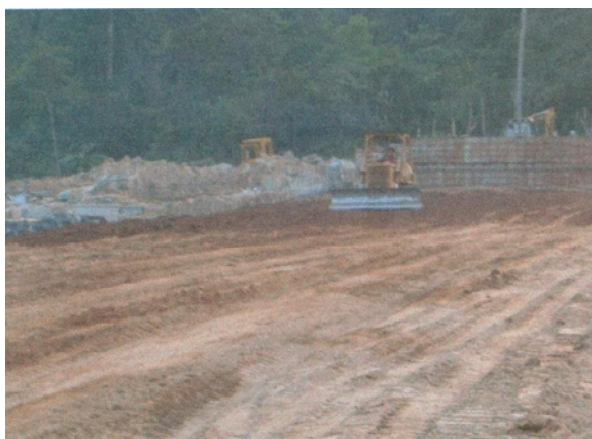
การก่อสร้างทำนบดินและอาคารระบายน้ำล้นของ อ่างเก็บน้ำห้วยจันทรวงศ์
