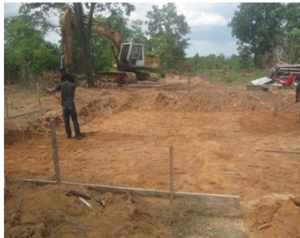
ขณะก่อสร้างบ่อพักน้ำ สาย MP
