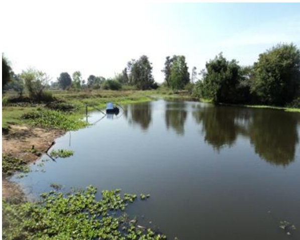
จุดก่อสร้างสถานีสูบน้ำด้วยไฟฟ้า
