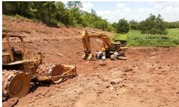
ขณะดำเนินการเปิดหน้าดิน
