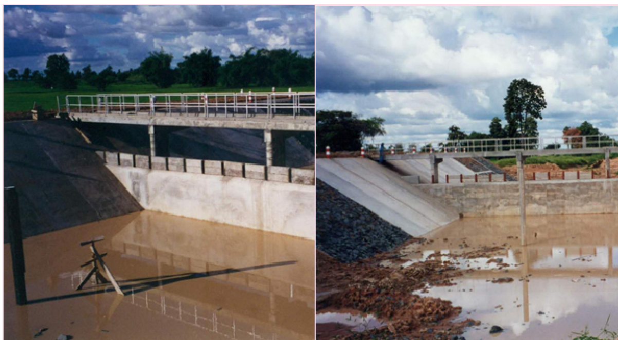
ฝายบ้านหนองไผ่น้อย 1 ขนาดฝายยาว 18 เมตร สูง 2 เมตร ฝายบ้านหนองไผ่น้อย 2 ขนาดฝายยาว 21 เมตร สูง 2.50 เมตร
