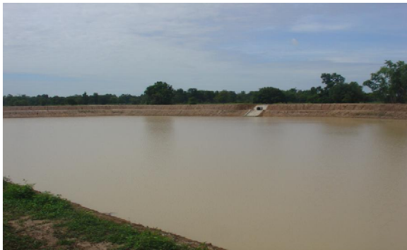
งานขุดลอกหนองหว้าที่ดำเนินการแล้วเสร็จ สามารถเก็บกักน้ำได้ ๕๐,๐๐๐ ลูกบาศก์เมตร
